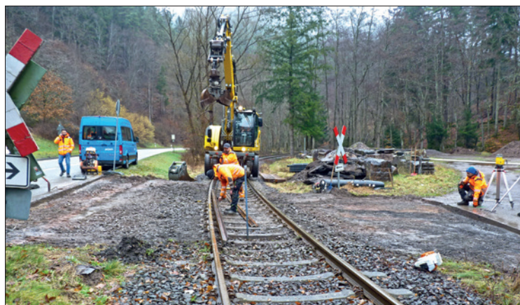
Auf dem Schotterbett neu verlegte Schwellen.
