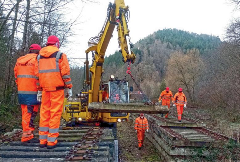
Erste Vorbereitung für die Gleisfelderneuerung: Fleißige Helfer verladen Betonschwellen zum Transport zur Baustelle.
