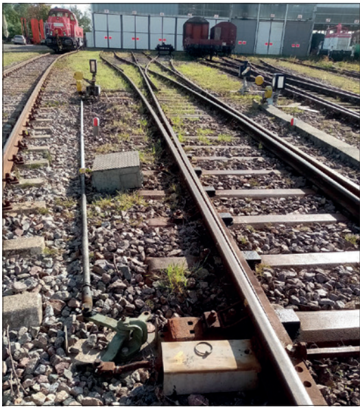
Der Weichenantrieb der Weiche 9 im Bw wurde umgebaut um das Lichtraumprofil zum Nachbargleis frei zu halten. Die Aufnahme entstand kurz vor dem Ende der Arbeiten. R. Frank
