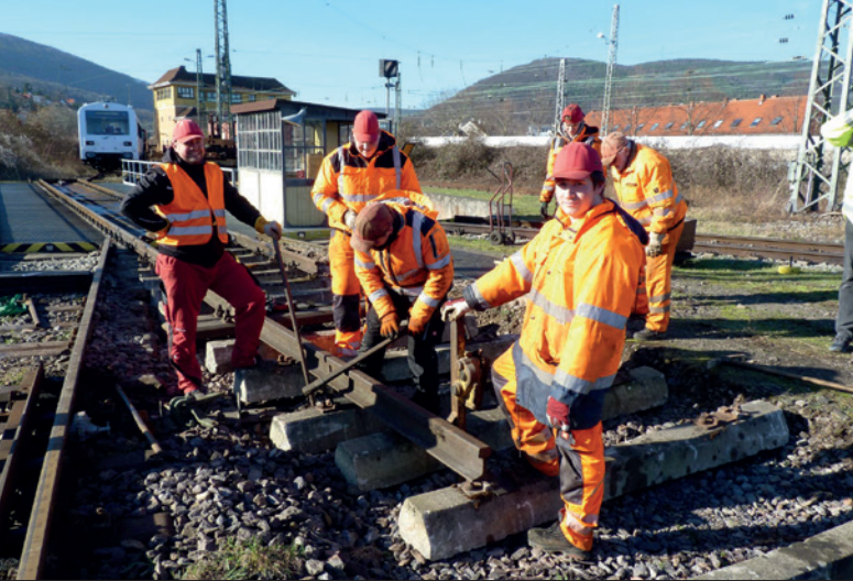
Die Bahnmeisterei Elmstein beim Verlegen der ersten Meter des neuen Gleis 58.
