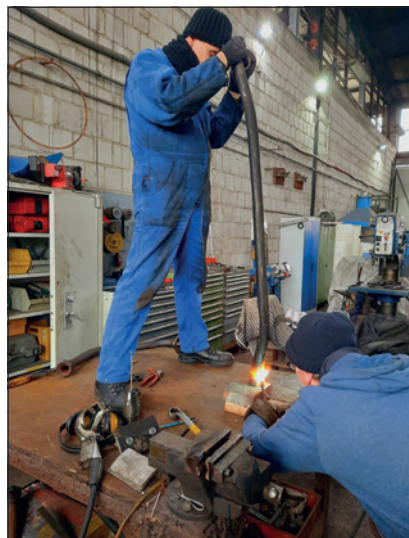
Matthias Dähling (links) und Hermann Gumbrecht (rechts) beim Hartlöten der Dampfzuleitung eines Injektors.
