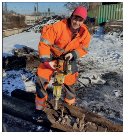
Felix Kempfer beim Abschrauben der Kleinenisen von Altschwellen.
