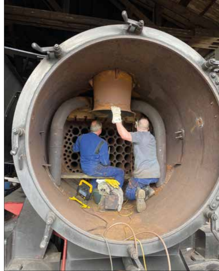
Meininger Fachkräfte bereiten den Einbau der Überhitzererelemente vor ...
