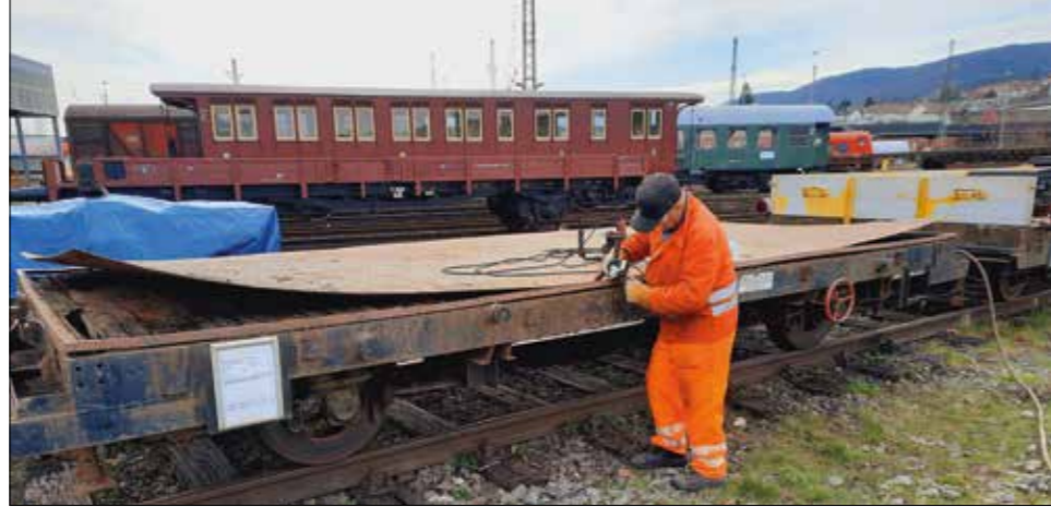
Bei diesem Anhänger musste das aufgeschweißte Deckblech entfernt werden, um die Holzbohlen darunter austauschen zu können. Jürgen Lemke
