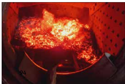
UNTE Blick in die Feuerkiste beim Putzen des Feuers: Die zu Platten zusammengebackene Schlacke wurde aufgerichtet und kann nun durch die Öffnung des Kipprosts in den Aschkasten gezogen werden.
