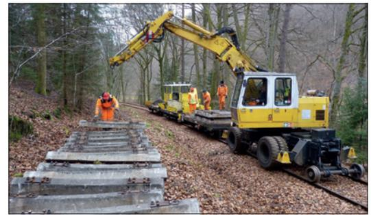
Im Bereich der nächsten Gleisbaustelle wurden auf einer Länge von 270 m bereits Betonschwellen ausgelegt. Reiner Frank
