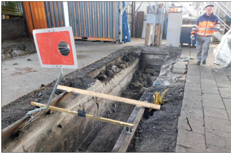
An den Enden der Gleise 59 und 60 mussten die Grubenwände im oberen Bereich komplett abgetragen und dann mit Beton neu gegossen werden.
