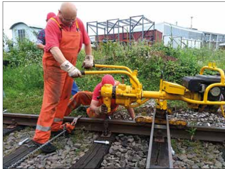
Im Einfahrgleis des Bw mussten bei mehreren Schwellen die alten Befestigungsschrauben durch verdübelte Schrauben ersetzt werden. Wolfgang Harsch
