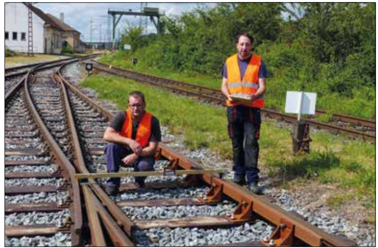
In regelmäßigen Abständen müssen Gleise und Weichen vermessen und dokumentiert werden, hier machen das Frank Muth und Daniel Heckmann.
