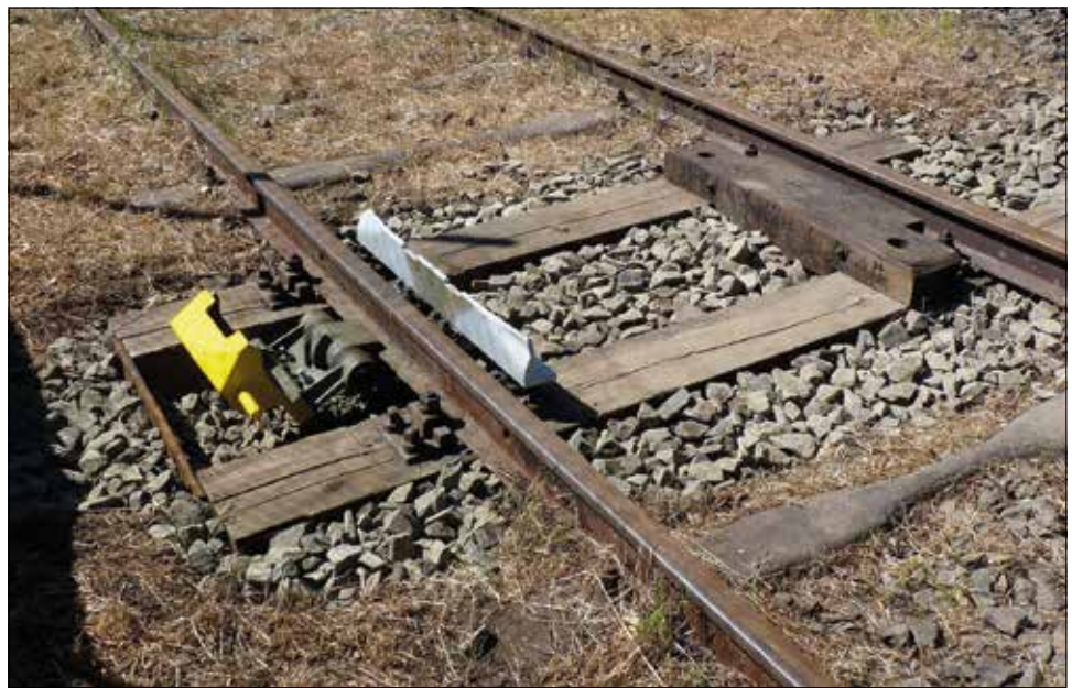
Im Abstellgleis des Haltepunkts Helmbach wurde eine neue Gleissperre eingebaut.
