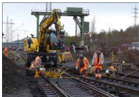
Austausch von Schwellen und Beseitigung von Spurerweiterungen.
