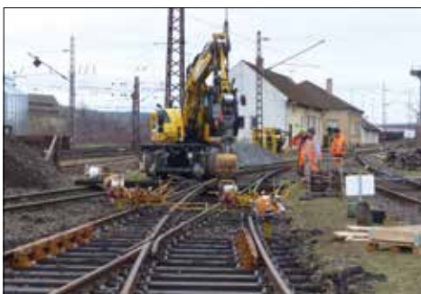
Austausch von Schwellen und Beseitigung von Spurerweiterungen.
