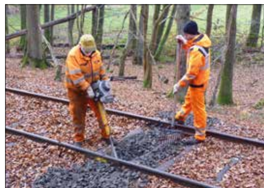
Wolfgang Harsch und Timo Frieß beim Stopfen einer neu eingesetzten Schwelle. R. Frank
